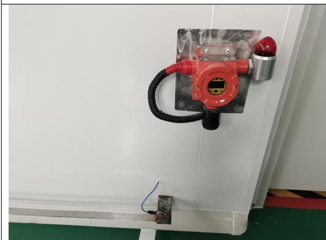
照片 5 合成车间固定式气体报警器
