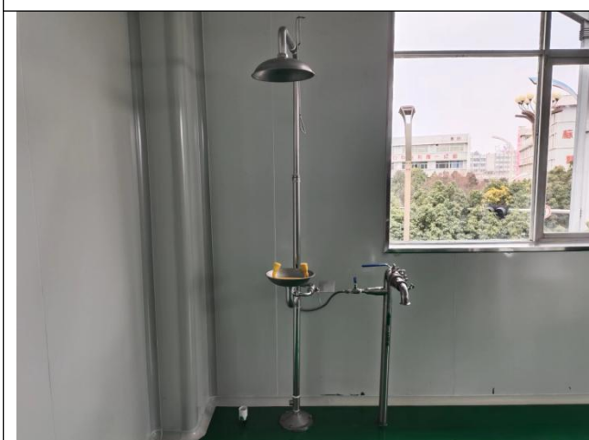
照片 9 合成车间喷淋洗眼器
