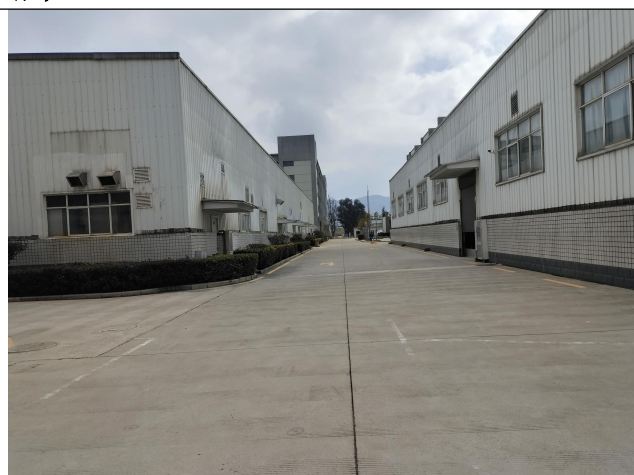
照片 2 厂区道路
