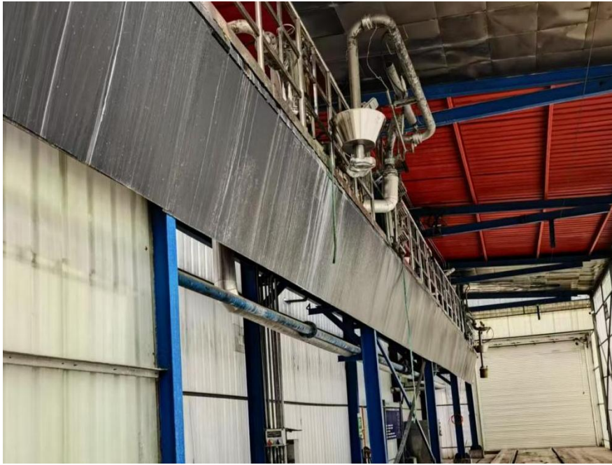
图 2-8 磷酸栈桥（内部）
